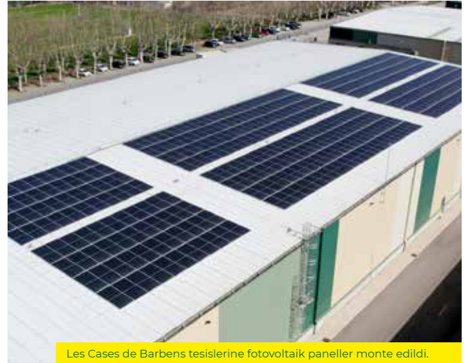
Les Cases de Barbens tesislerine fotovoltaik paneller monte edildi.
